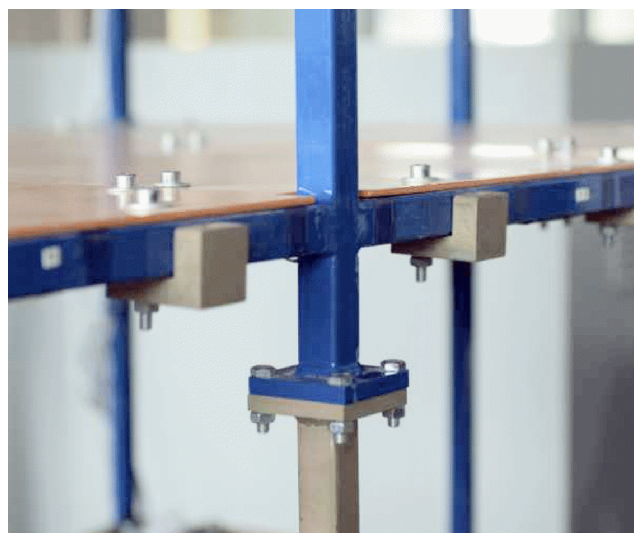
б) Узел крепления съёмного опорного стержня
