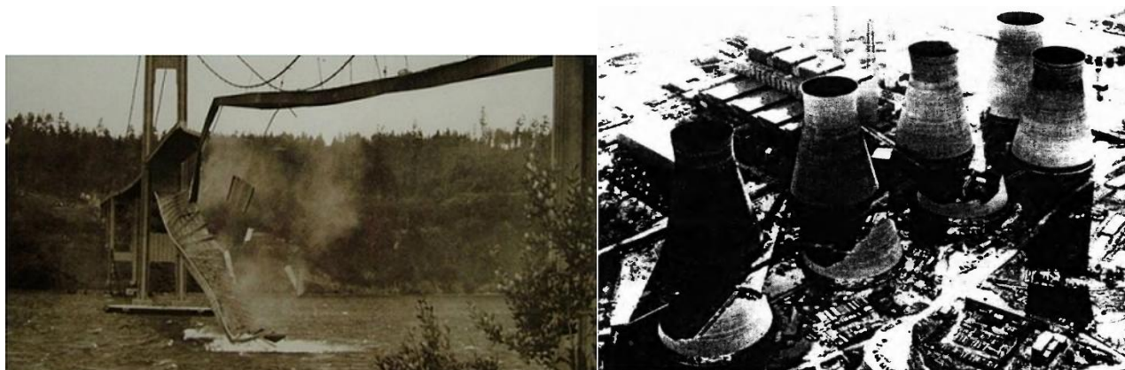
Рис. 1.1. Слева : обрушение Такомского моста 7.10.1940 г. Последствия в результате возникновения аэродинамической неустойчивости – изгибно-крутильного флаттера . Справа : обрушение градирен на ТЭС Феррибридж 1.11.1965 г. Последствия в результате возникновения аэродинамической неустойчивости – автоколебания в аэродинамическом следе
