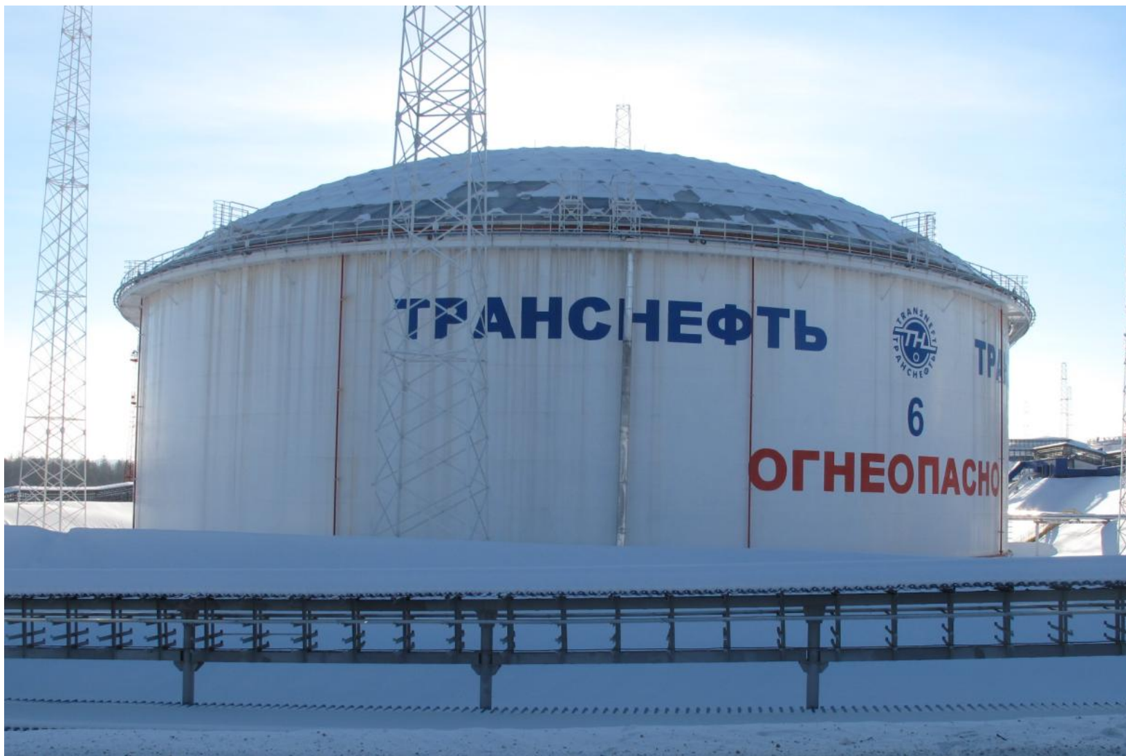
Рис. 4.1. Резервуар РВСПА-50000 с нефтью в сейсмически активном районе. Общий вид
