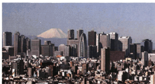
Рисунок 1.2 — Существующая застройка района Синдзюку.
