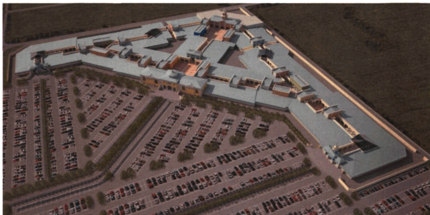
Рисунок 5.28 — Общий вид комплекса по завершении строительства.
