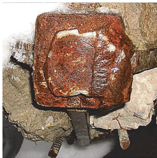
Рис. 6. СОК "Трансвааль-парк". Разрушение оголовка ряда колонн по результатам численного эксперимента (сварные швы условно не показаны) и натурных съемок
